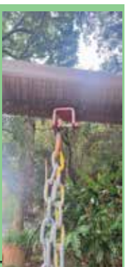
Parafuso que prende a corrente do balanço (desgastado)
